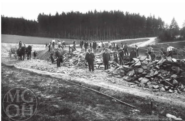
Stavba silnice k chatě 17. 9. 1929 - 5. 4. 1931 (Okresní silnice Vamberk – Bednářova chata)
