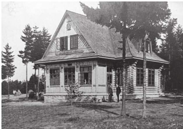
Chata na Bednářově vyhlídce realizována během 4 měsíců
