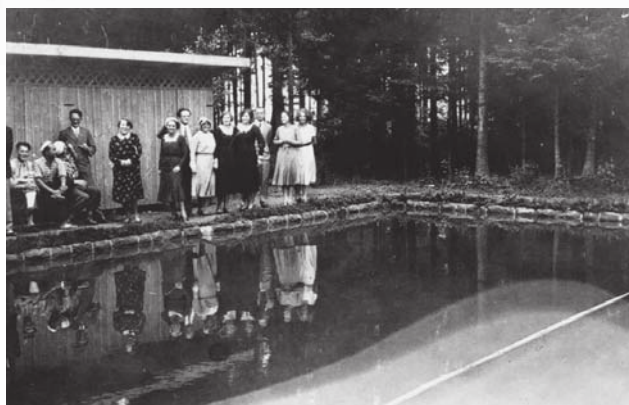
Koupaliště u chaty Na Vyhliďce sloužící jako zásobárna vody postaveno v roce 1930
